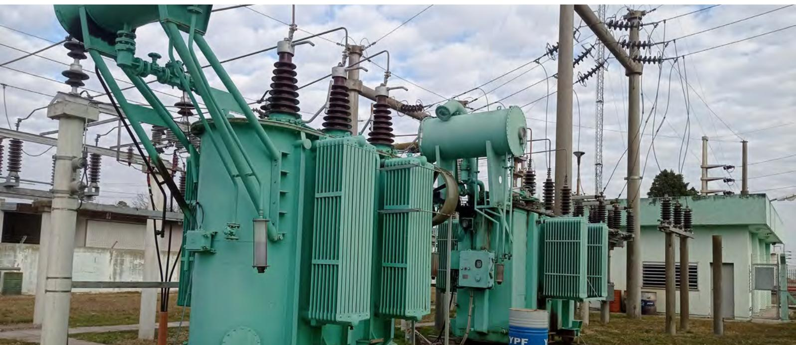
Se ha adquirido un nuevo transformador de una potencia de 22 MVA (el doble de la potencia instalada hoy), así como un disyuntor de 66KVA y uno de 13,2KVA (ambos de altísima potencia), para poder manejar este equipo.
