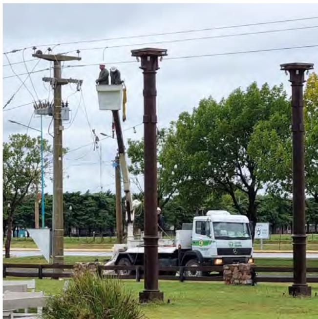
El domingo 20 de marzo, EPEC realizó un corte de energía de seis horas de duración que afectó a varias localidades de la zona, para realizar trabajos en la Estación Transformadora Villa del Rosario. Cambiaron un seccionador de 66kV en línea salida Pilar y un transformador de intensidad totalizador en barras 13kV. Además, repararon la línea de 66kV que ingresa a la Estación Transformadora Luque.
