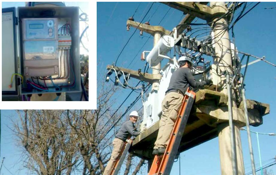
En el año 2018 instalamos “medidores inteligentes” en todas las subestaciones transformadoras de la localidad, con el objetivo de eficientizar el servicio de energía. Estos medidores controlan el estado cada subestación de manera permanente, brindando estadísticas de consumo en tiempo real. Esto permite evaluar el comportamiento de cada una a fin de planificar mejor el sistema eléctrico y así evitar posibles cortes por sobre carga de consumo.
