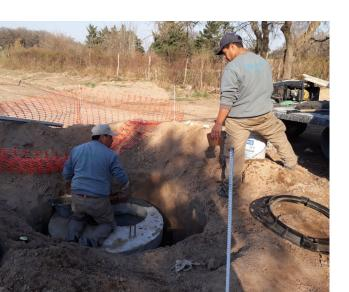
Continuamos con la obra de cloacas en este sector del pueblo, el único que no contaba con dicho sistema hasta el momento. Ya finalizamos la etapa de construcción de redes troncales y ahora estamos instalando las cámaras de inspección en la esquinas. Mientras tanto, se está avanzando con el Municipio para definir el proyecto que posibilite a los vecinos conectarse a este servicio.
